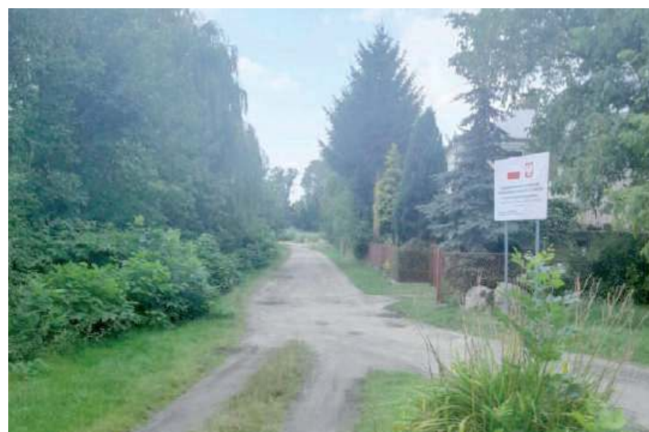
Tablica informacyjna już stoi. Przebudowa 338 metrów tej ulicy potrwa do listopada. Po zakończeniu prac ludzie i pojazdy będą poruszać się po nawierzchni z kostki betonowej
