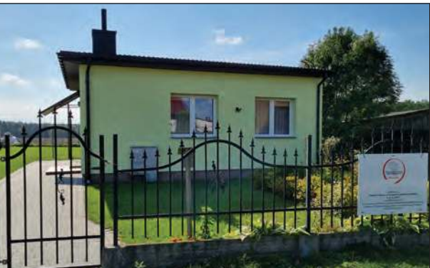
Koszt prac w Lipnikach to 34 tys. zł
