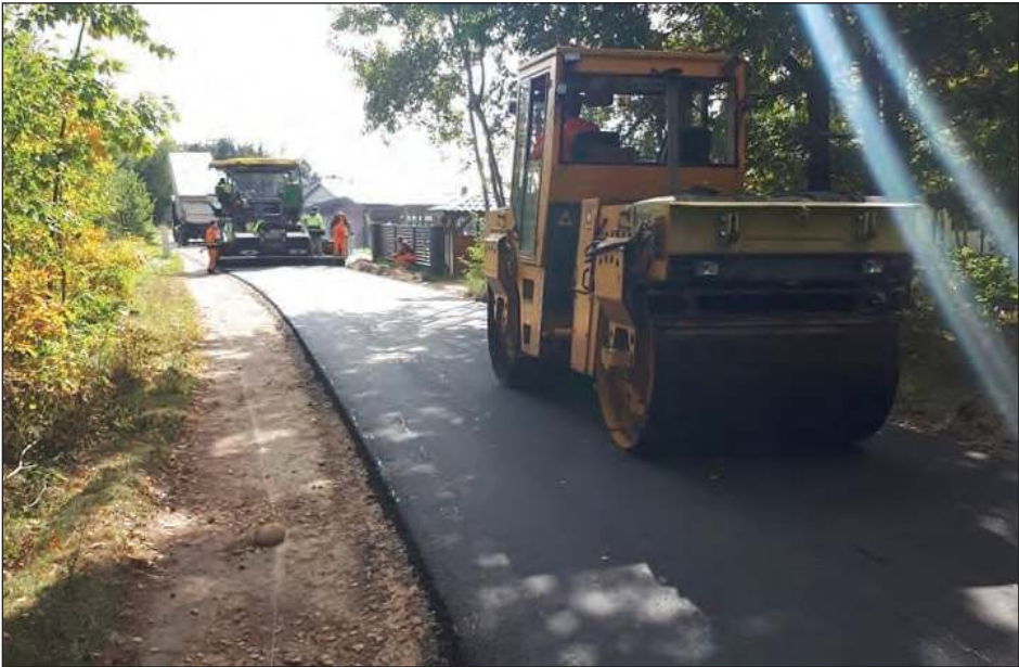
W minionym tygodniu przebudowano między innymi ponad 400-metrowy odcinek ulicy Leśnej
