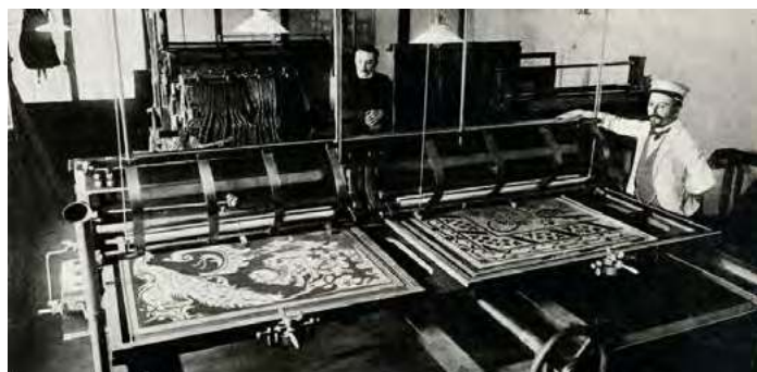
Fotografia 6, 7. Tkanie gobelinów metodą Szczepanika i opatentowana przez niego maszyna tkacka Źródło: https://upload.wikimedia.org/wikipedia/commons/8/8e/Automatic_loom_with_patents_of_Jan_Szczepanik.jpg
