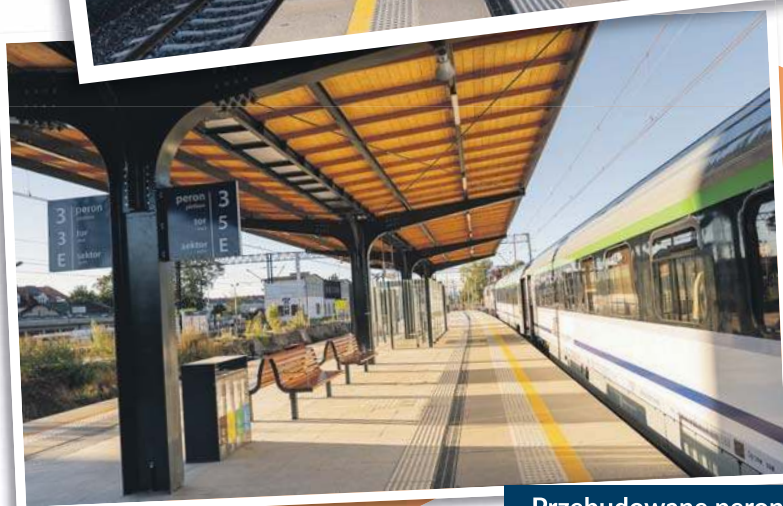
Przebudowane perony na stacji Słupsk
