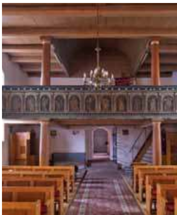
W ramach prac odnowiono parapet empory oraz 16 obrazów umieszczonych w jej arkanach
