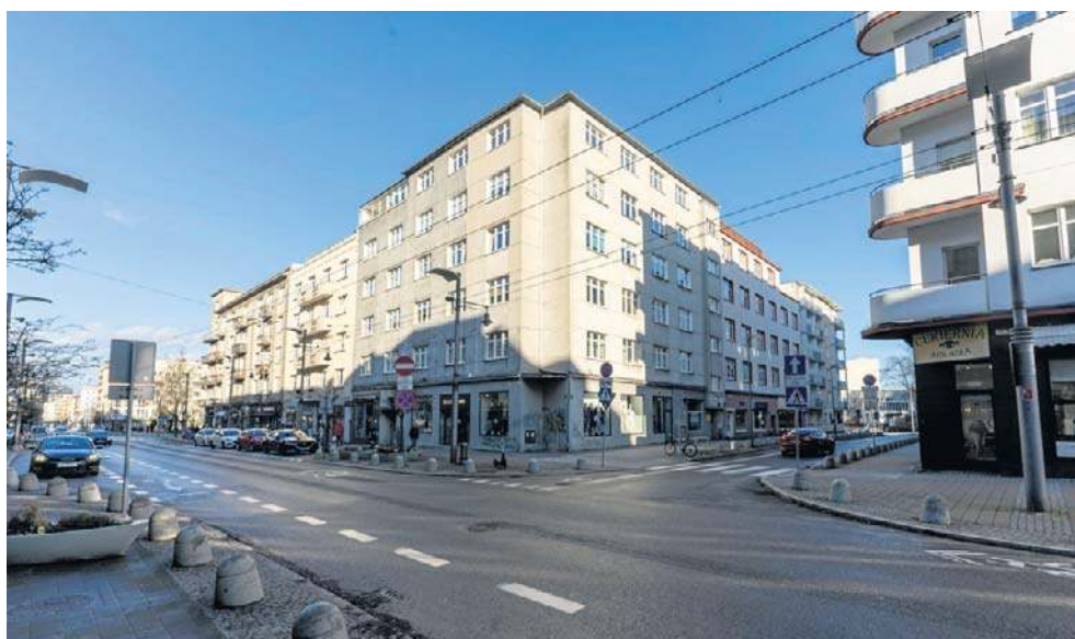
Świętojańska jest jedną z ulic, które zostaną objęte częściową przebudową
