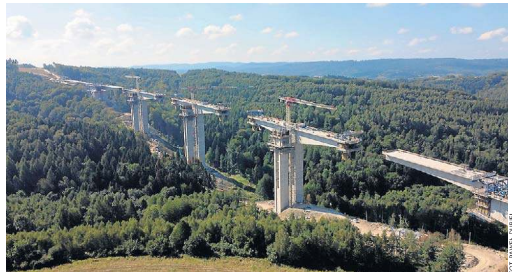
Ustrój nośny estakady wznosi się nad dnem doliny na wysokość blisko 120 m, a filary sięgają 80 m, co stanowi najwyższy wynik w Polsce
