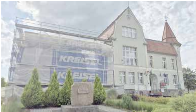
UM w Dobrzanych w budowie i remoncie
