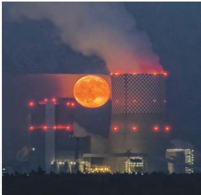
Księżyc nad blokiem 910 MW w elektrowni w Jaworznie
