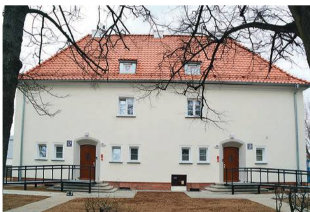
Tak prezentują się wyremontowane budynki przy ul. Sienkiewicza i 17 Stycznia.
