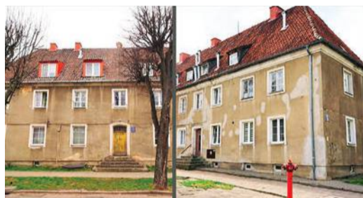
Ratusz pozyskał środki zewnętrzne na termomodernizację bloków przy ul. Okrzei 5 i 12.
