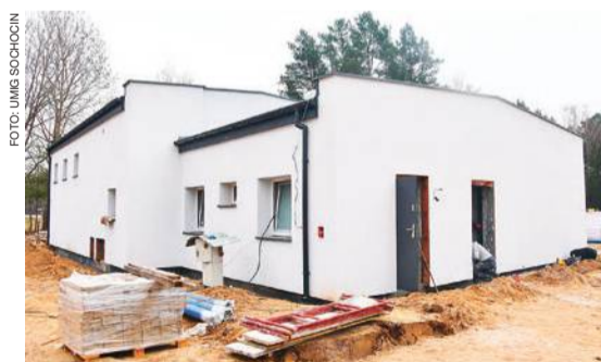
Prace związane z przebudową SUW w Rzach zmierzają ku końcowi
