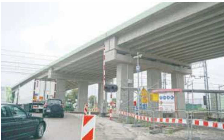
Wiadukt w Łochowie
