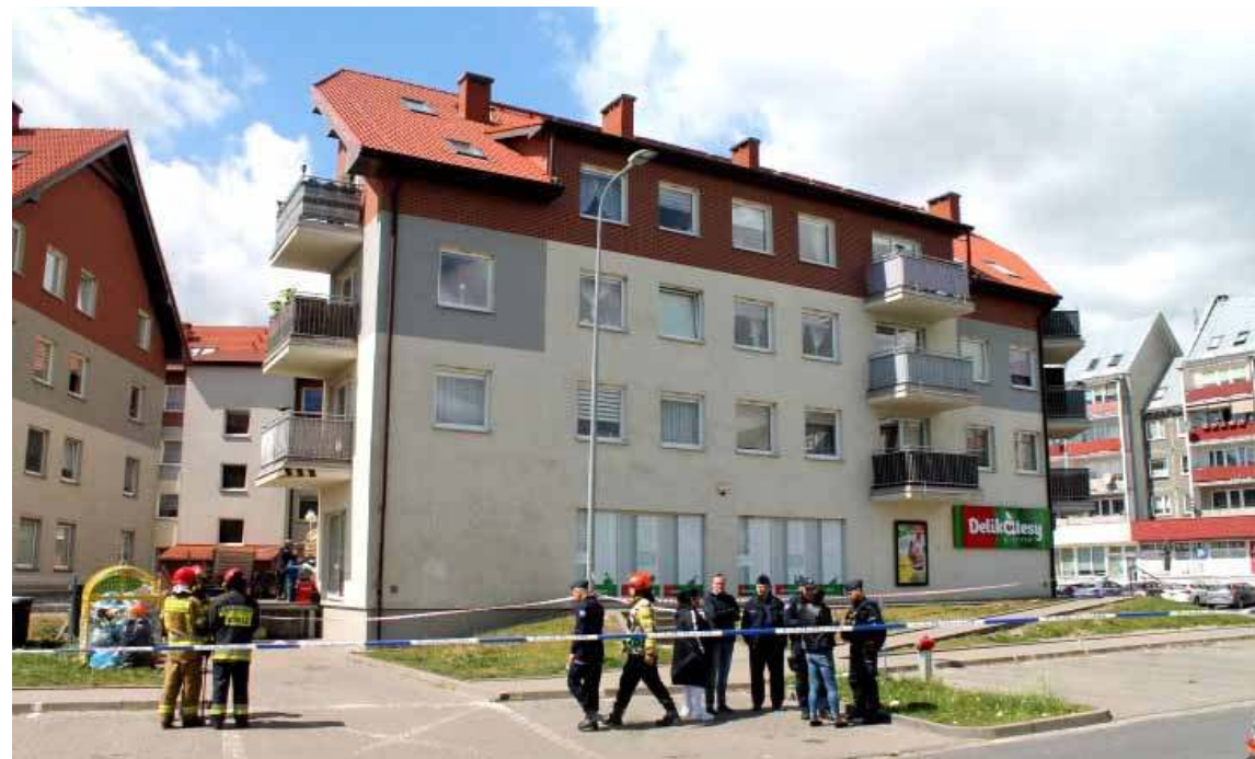
Budynek mieszkalny przy Armii Krajowej na Os. Pyrzyckim został wczoraj wyłączony z użytkowania
