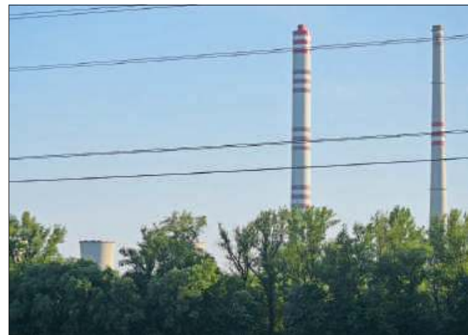
Kominy elektrowni doskonale widać z Godowa
