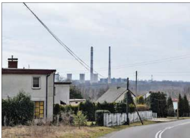
Elektrownia Dětmarovice – EDA – sąsiaduje bezpośrednio z Godowem
