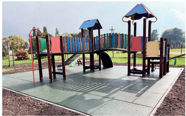
Wykonanie bezpiecznej nawierzchni na placu zabaw w Strzałkowie
