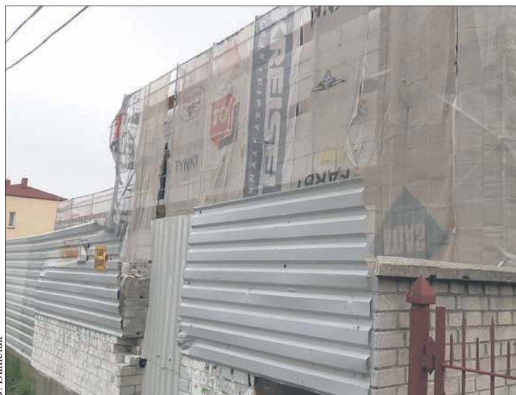
Budowa żłobka pomiędzy ulicami Polną i Kazimierza Wielkiego
