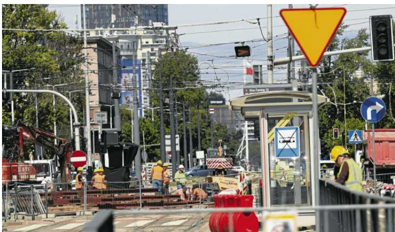
• W Warszawie nadal trwają remonty torowisk, wiele linii tramwajowych ma zmienione trasy FOT. SŁAWOMIR KAMIŃSKI / AGENCJA WYBORCZA.PL
