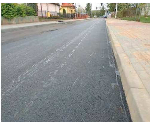
Fragment zmodernizowanego odcinka ulicy Studzieniec
