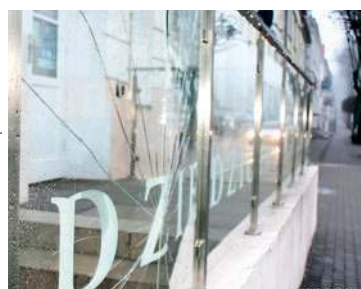
Zniszczona balustrada przed wejściem do Centrum Dziedzictwa Kulturowego; sprawca został zatrzymany
