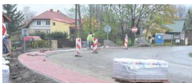
Chodnik budowany jest na 630 m odcinku, od kościoła w Wilkowie w kierunku wsi Dobrze
