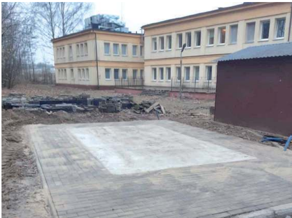
Przy szpitalu wylana została już płyta fundamentowa, na której zamontowany będzie zbiornik na tlen o pojemności 5-7 tys. litrów
