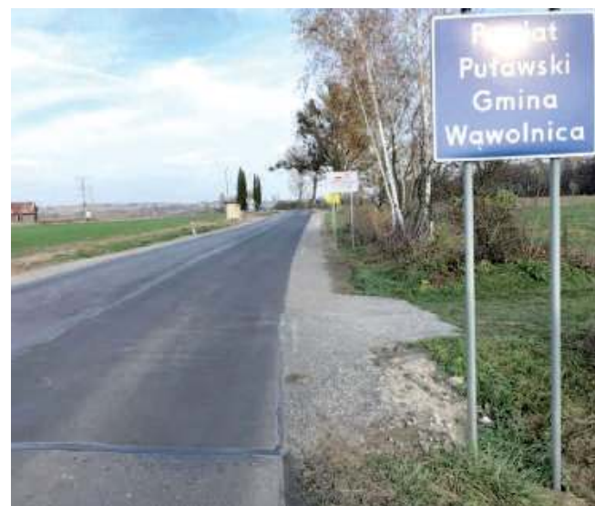
Teraz na całej długości drogi na terenie powiatu puławskiego jest nowy równy asfalt
