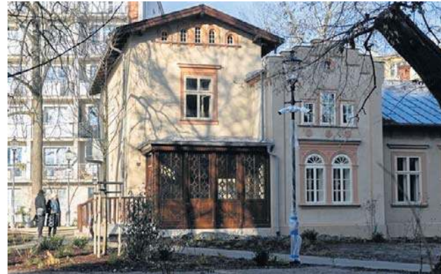
W Kossakówce trwają ostatnie prace kosmetyczne
