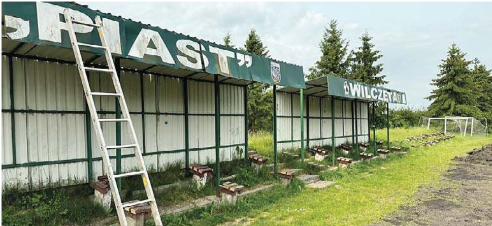
Ostatnie spojrzenie na stare trybuny. Rozpoczęcie prac oznacza nowy etap w historii sportu w Wilczętach — inwestycja znacząco poprawi warunki do prowadzenia zajęć wychowania fizycznego i rekreacji
