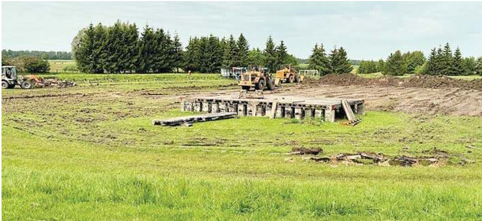
Ciężki sprzęt na placu. Ruszyły prace ziemne w związku z największą inwestycją sportową ostatnich lat w Wilczętach
