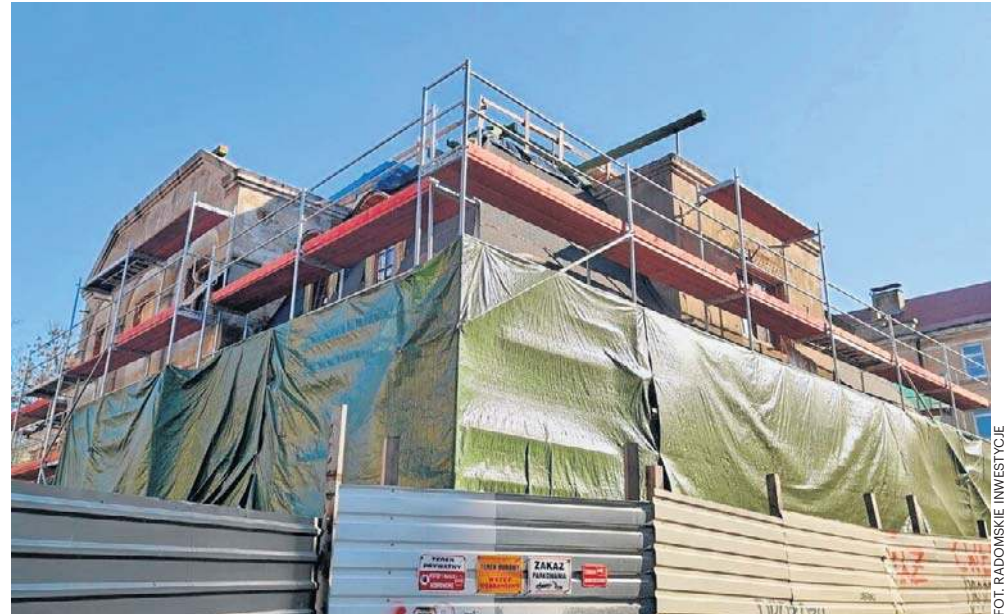
Budynek „Starej Łaźni” w Radomiu zachowa swój zewnętrzny wygląd, ale wnętrze będzie dość znacznie przebudowane.
