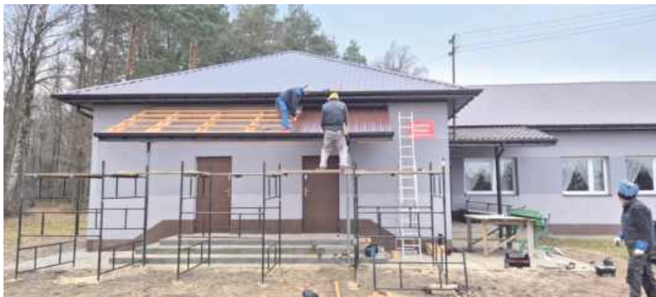
Dzięki funduszowi udało się wykonać m.in. remonty dróg, modernizacje świetlic, doposażenie strażnic OSP oraz budowę placów zabaw
