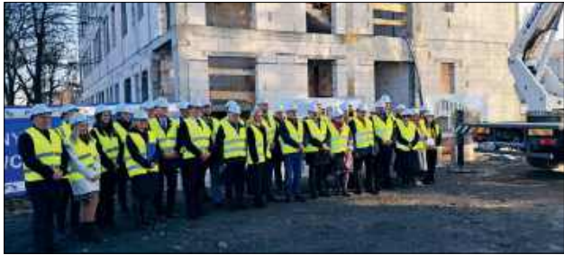
Ukończono już pierwszy etap prac – stan surowy. Uroczystość zawieszania wiechy odbyła się 5 listopada, a nowy budynek starostwa zostanie oddany do użytku w marcu 2027 roku
