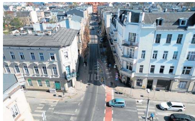
Prace w tym tygodniu ruszą na ul. Pomorskiej
