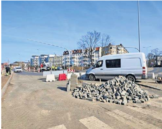
Budowa odcinka trasy staromostowej trwa od roku. Pojedziemy nim między 13 a 23 marca
