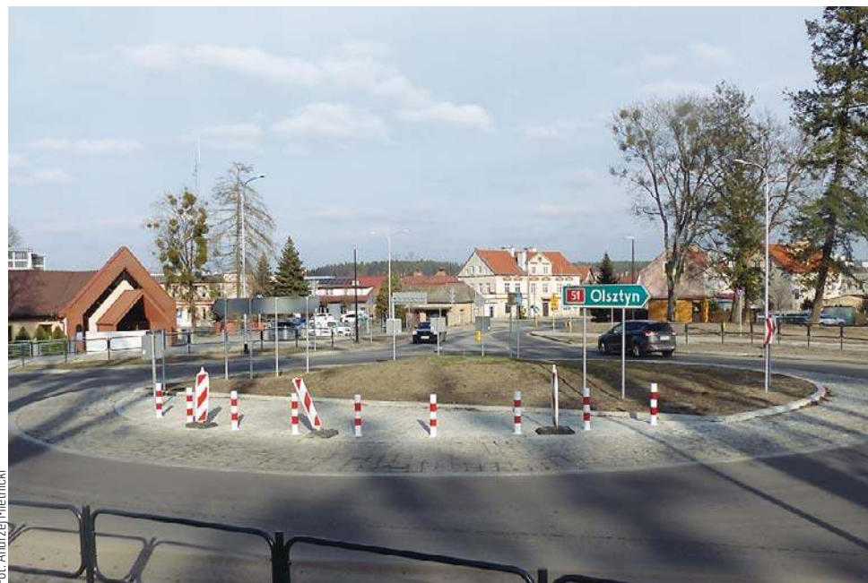
Wykonawca wywiązał się z zadania przed terminem
