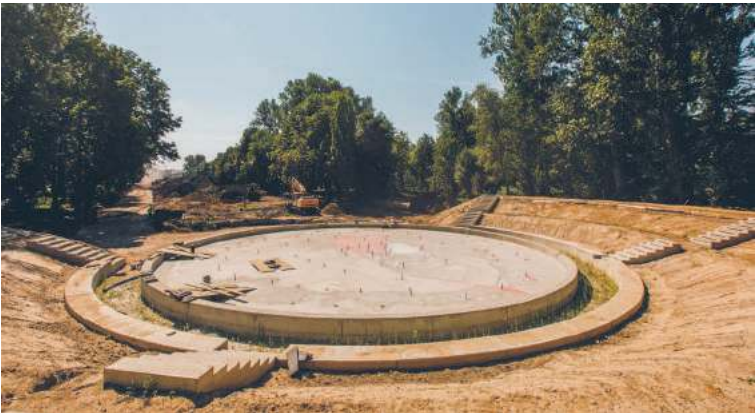
W Parku Ludowym prace przebiegają zgodnie z przyjętym harmonogramem. Odnowiony park powinien zostać otwarty dla mieszkańców późną jesienią.
