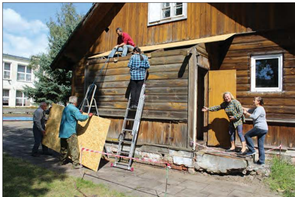
■ W 2017 roku urząd dał 2 tys. zł na zakup materiałów, aby poprawić stan budynku. Społecznicy pokryli papą około 160 m 2 dachu, wybudowali dwa nowe kominy z klinkieru i pokryli płytą OSB dobudowaną toaletę
