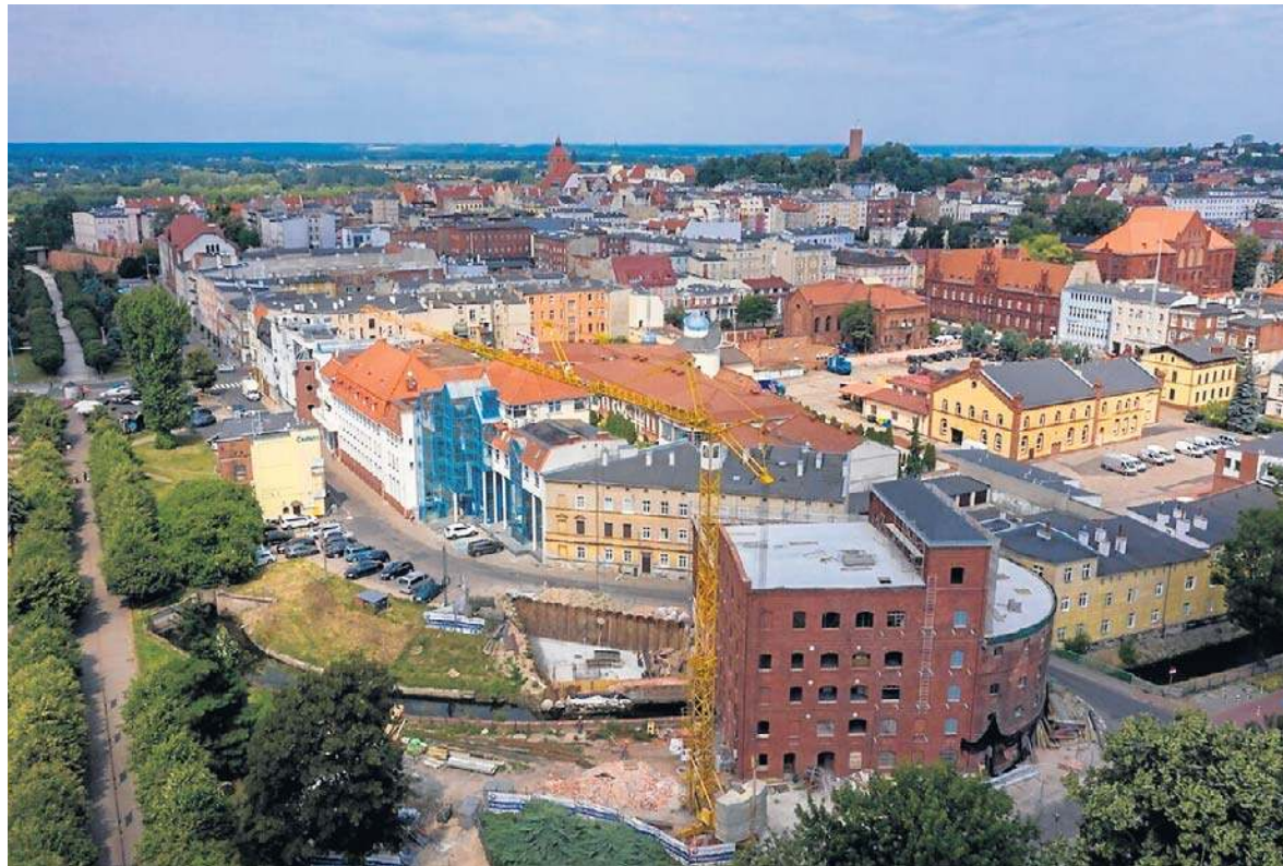
W Grudziądzu trwa budowa „Młynu Energii”. To jedna z największych inwestycji w mieście, dofinansowana z funduszy europejskich. Ciekawostka: płynie pod nią kanał Trynka. Wszelkie instalacje wykonuje Logon
