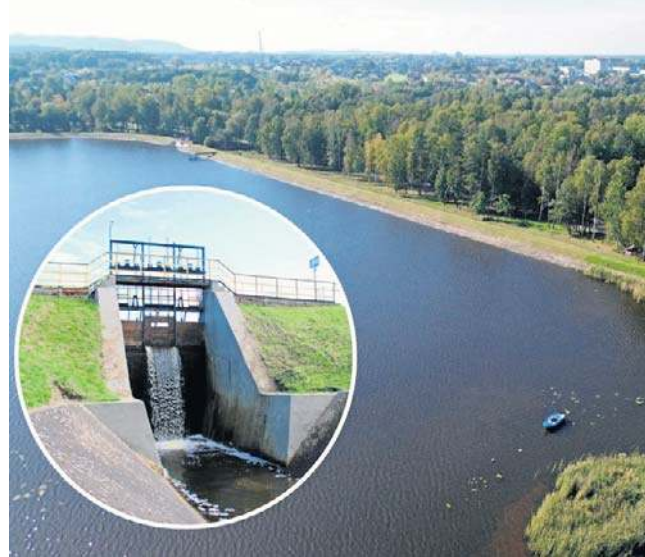
Zalew Chechło. W tym roku nie rozpoczną się prace związane z remontem i modernizacją wałów i jazu
