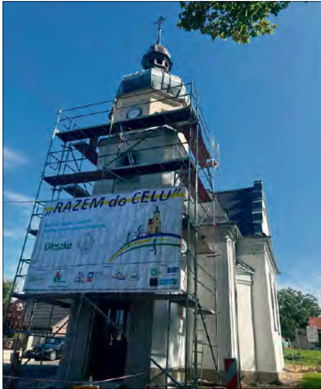
Zakończenie prac remontowych zbiega się z obchodami 150-lecia budowy kaplicy, które zaplanowano na 3 października.
