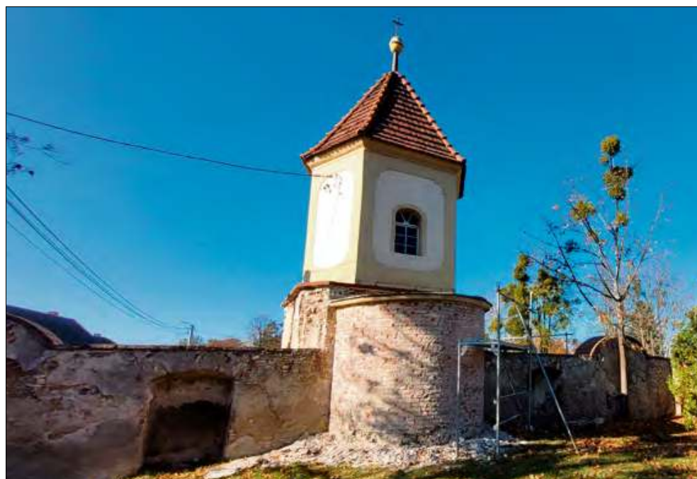
Remont kapliczki – chwila, w której zamknięto kapsułę czasu, zapisując na nowo historię wsi.
