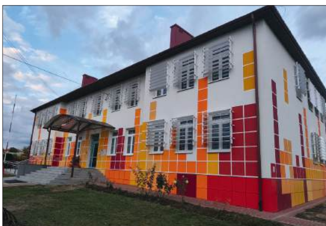
Zmodernizowany budynek szkoły podstawowej w Zdziarcu.
