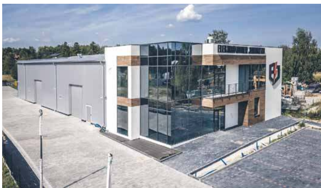
Realizacja inwestycji w Jaworznie
