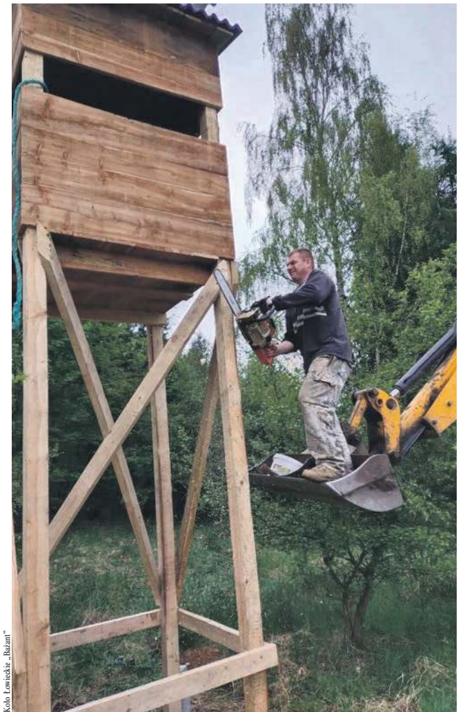
Prace gospodarcze. Budowa ambony
