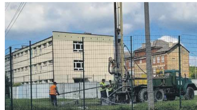
Prace przy SP nr 5 w Sierszy
