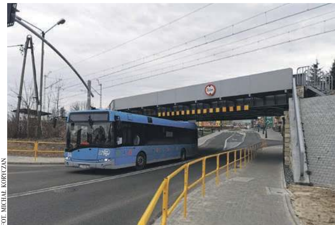
Po otwarciu zmodernizowanego wiaduktu na Krakowskiej w Chrzanowie niektóre autobusy jeżdżą tam na skróty, nie objeżdżając już miasta ul. Oświęcimską i Sienną
