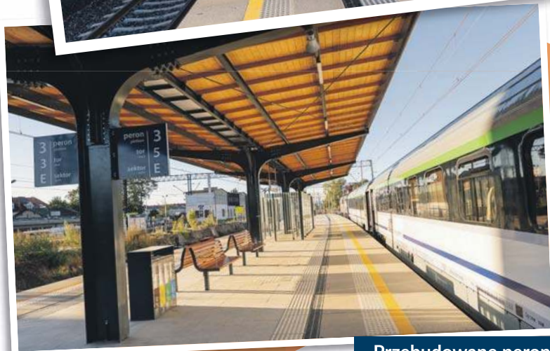
Przebudowane perony na stacji Słupsk
