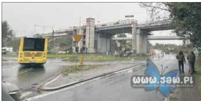
Budowa przystanku kolejowego Sosnowiec Jęzor Południowy
