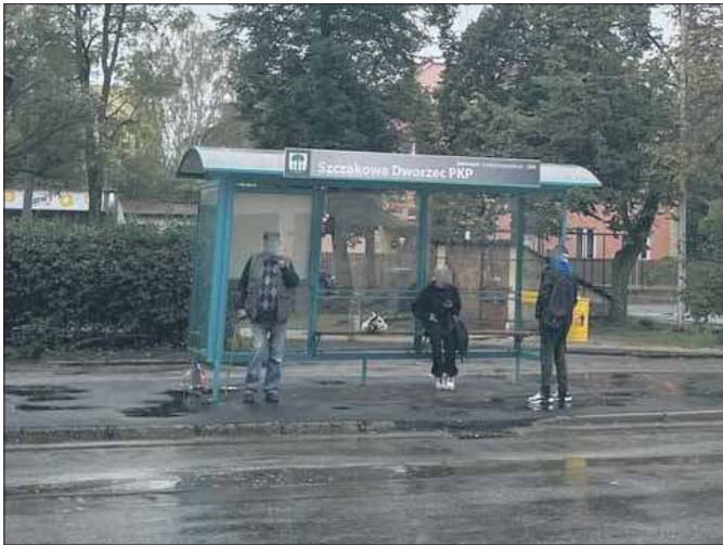
Nowa wiata przystanku Szczakowa Dworzec PKP
