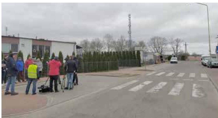
Pierwsze z widocznych pasów powinny zostać jak najszybciej zamazane. Prawidłowe przejście powinno być oznakowane nie tylko poziomo, ale i pionowo
