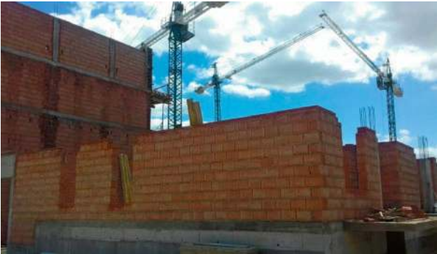
Powoli rośnie też budynek A11 – prace nad ścianami zewnętrznymi kondygnacji podziemnej przekroczyły półmetek
