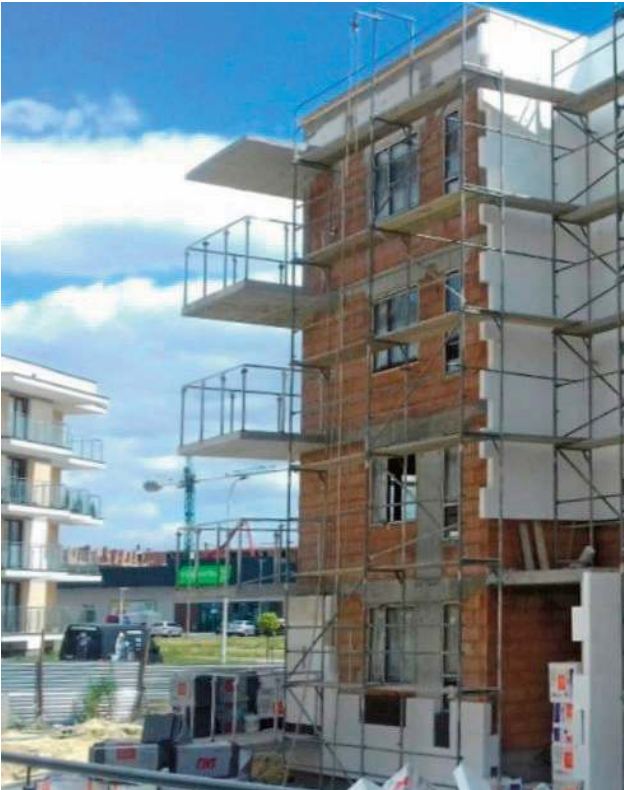
LONDYN, OSIEDLE EUROPEJSKIE A5 – od strony południowej i patio trwają prace nad wykonaniem elewacji budynku, a w klatkach II i III rozpoczęło się układanie tynków
