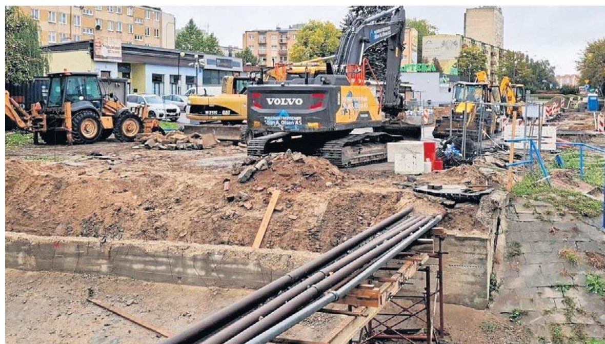
W tym miejscu ulicy Chrobrego w Radomiu powstaje nowy most nad Potokiem Północnym.
