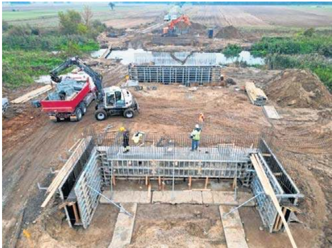
Tak obecnie wygląda stan budowy nowego mostu na Radomce w gminie Jastrzębia.
