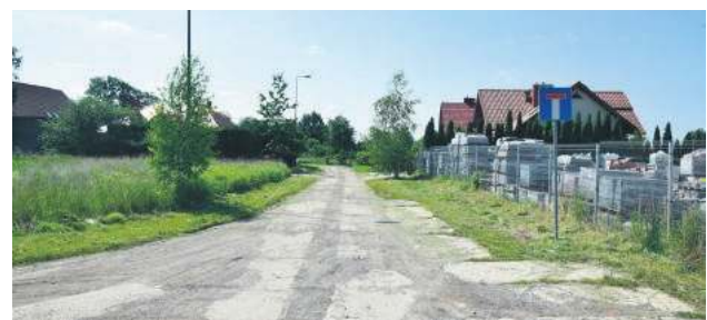
Nowe drogi przy ul. Królowej Bony, Królowej Jadwigi i Dąbrówki o łącznej długości 476 m powinny być gotowe do połowy listopada.
