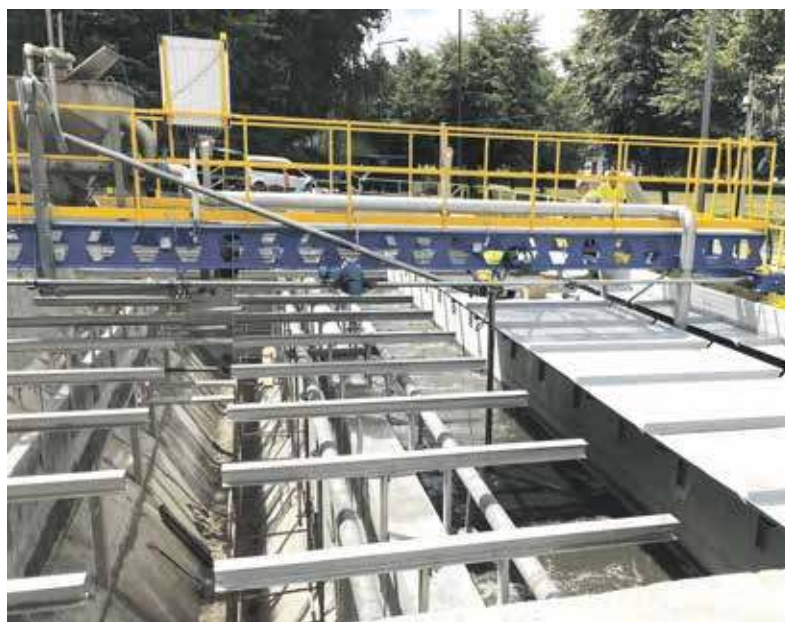
Na Dworcowej BPK wybudowało 843 m sieci wodociągowej wraz z przyłączami do okolicznych budynków
