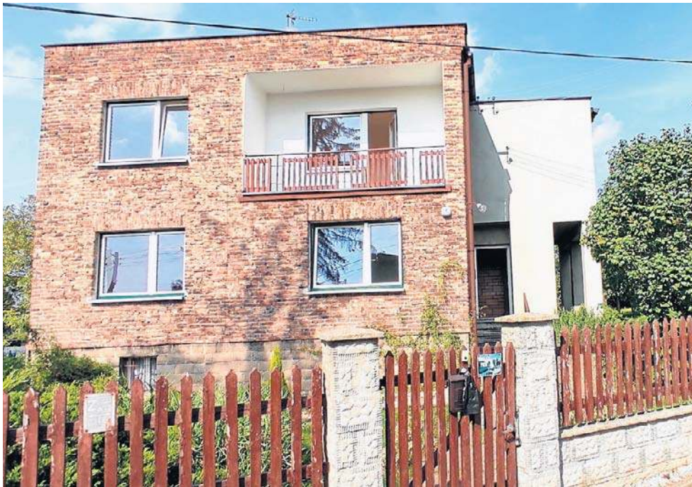
Decyzja o remoncie domu kostki nie zawsze jest oczywista. Wiele zależy od stanu budynku, ale też potrzeb inwestora
