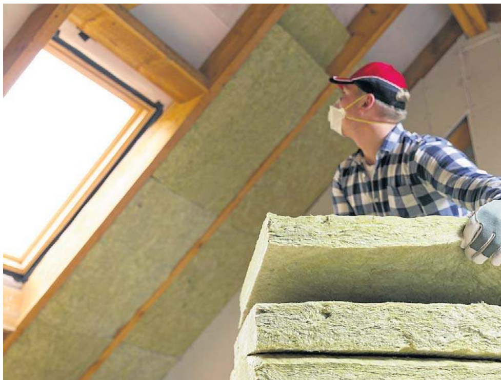
W budynkach bezemisyjnych nie będzie można stosować źródeł ciepła, chłodu i energii elektrycznej emitujących na miejscu dwutlenek węgla z paliw kopalnych
