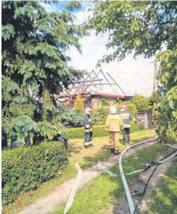
Ogień szybko rozprzestrzenił się po drewnianej konstrukcji dachu. Fot. OSP Sucha
