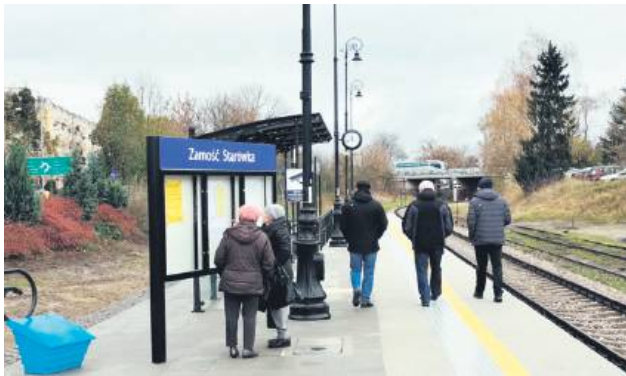
Od końca ub. roku pasażerowie mogą korzystać ze zmodernizowanego przystanku Zamość-Starówka. Fot. PKP Polskie Linie Kolejowe
