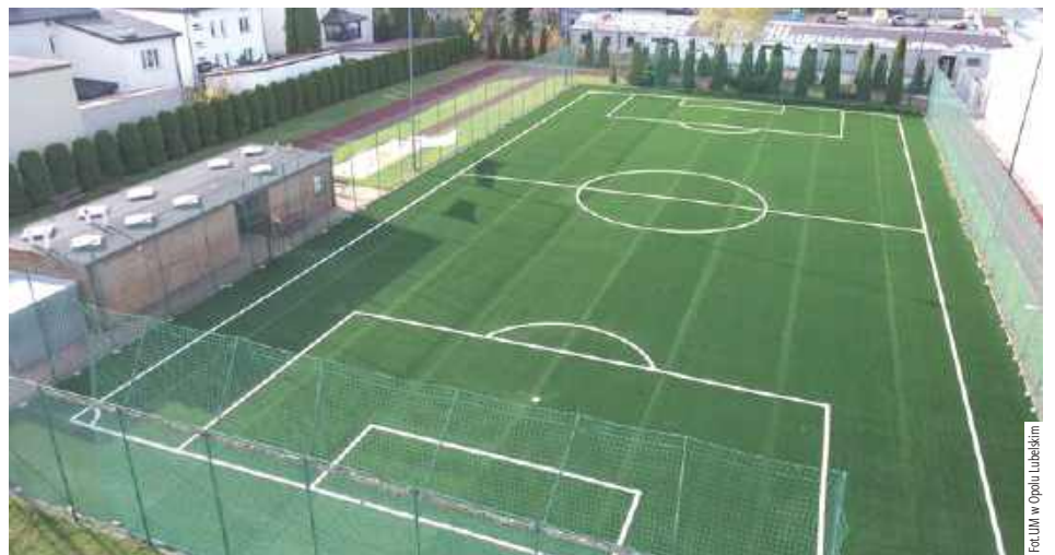
Po kilku tygodniach intensywnych prac mieszkańcy mogą już korzystać z odnowionego obiektu
