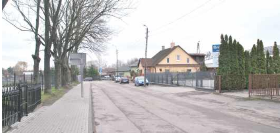
Ulica Kolejowa w Opolu Lubelskim od dawna aż prosiła się o remont
