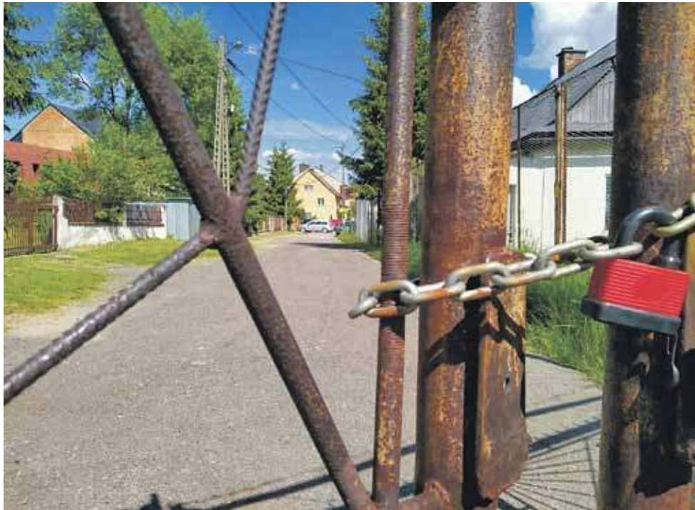
Kłódka na bramie, a za nią dalszy ciąg ścieżki rowerowej.
