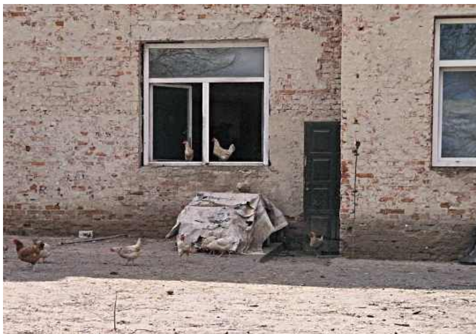
Dawniej była tu szkoła. Teraz budynek pełni funkcję kurnika. Czy w przyszłości będzie meczet?
