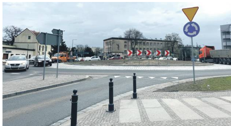
Strzeleńskie rondo po przebudowie
