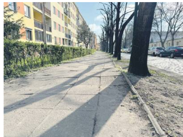
Chodnik przy ul. Staszica w Strzelinie jest w złym stanie. Korzenie drzew podnoszą betonowe płyty, tworząc liczne nierówności
