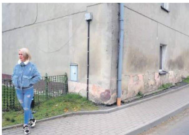
Odpadający tynk z elewacji domu przy drodze wojewódzkiej. Zabezpieczeniem ma się zająć DSDiK w Wrocławiu
