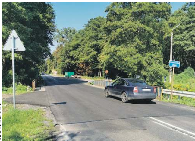
Most na ul. Oświęcimskiej w Wygielzowie
