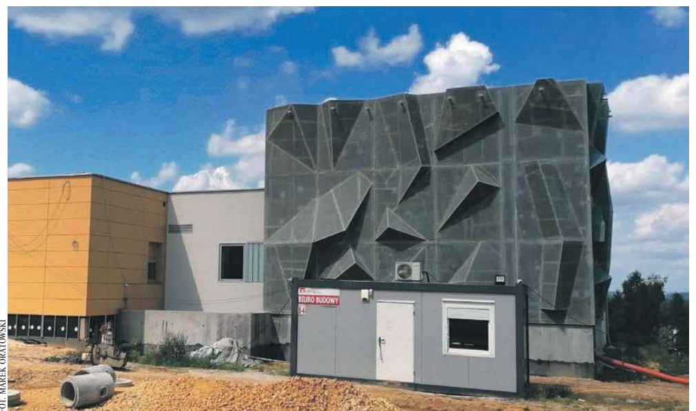
Przy krytej pływalni budowanej na osiedlu Flagówka znajdzie się zewnętrzna ścianka wspinaczkowa. Już można ją oglądać. Zmieni się jeszcze tylko jej kolorystyka
