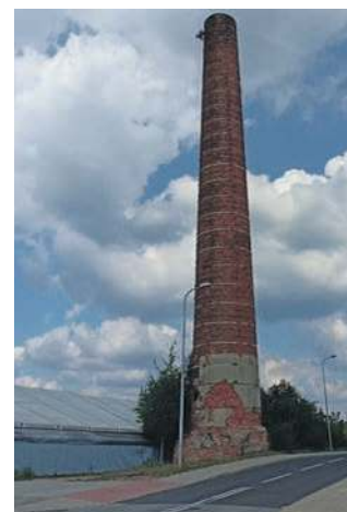
Komin na ul. Ochronkowej
